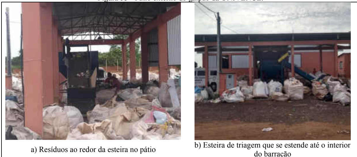
Figura 53 - Pátio externo do galpão da UNIVENCE.
