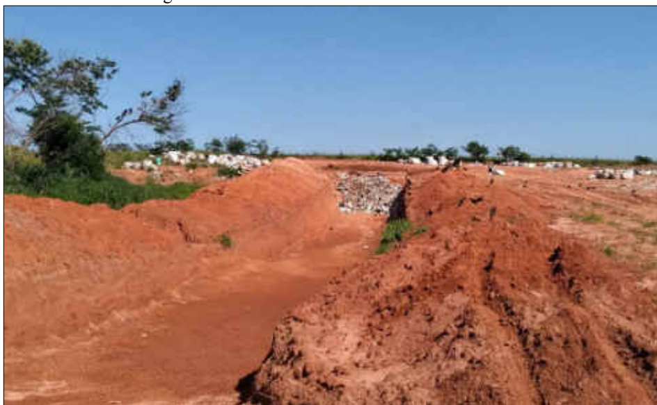
Figura 71 - Aterro controlado de Santo Anastácio.
