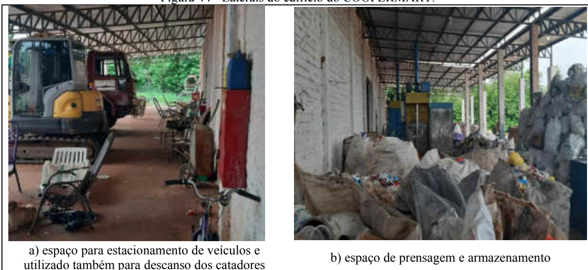
Figura 44 - Laterais do edifício do COOPERMART.
