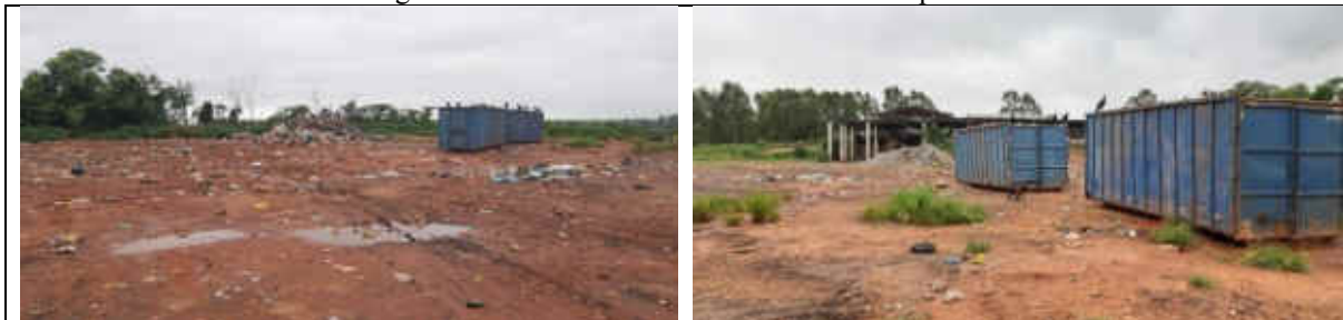
Figura 65 - Unidade de transbordo de Martinópolis.
