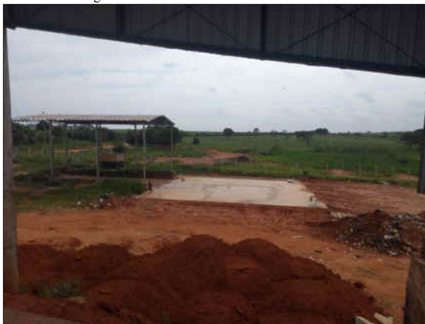
Figura 67 - Unidade de transbordo de Rancharia.
