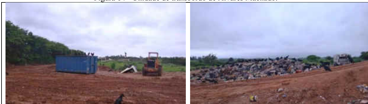
Figura 64 - Unidade de transbordo de Álvares Machado.
