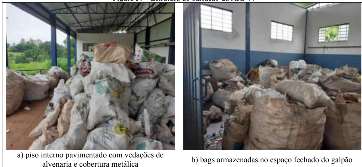
Figura 39 - Estrutura do barracão da ARPV.
