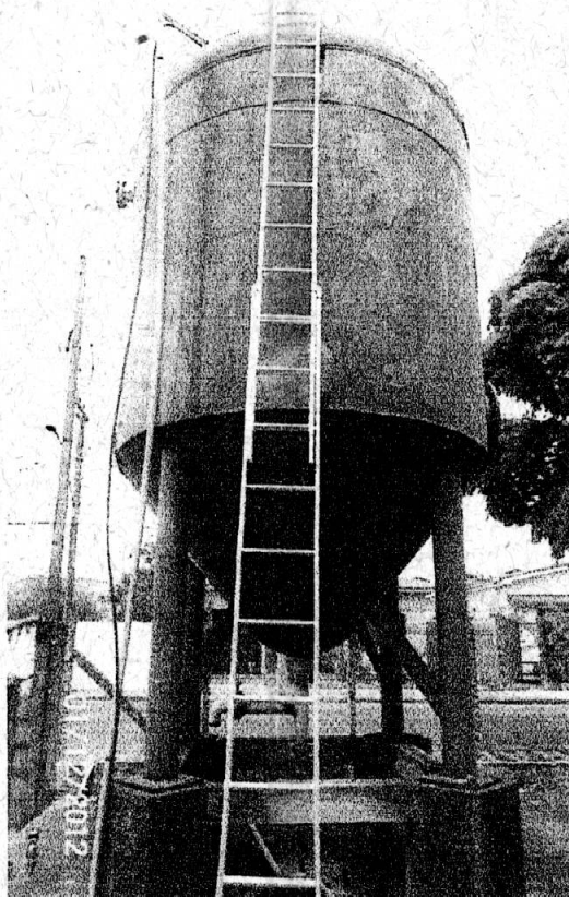
Foto 7 – Parte Externa do Reservatório
