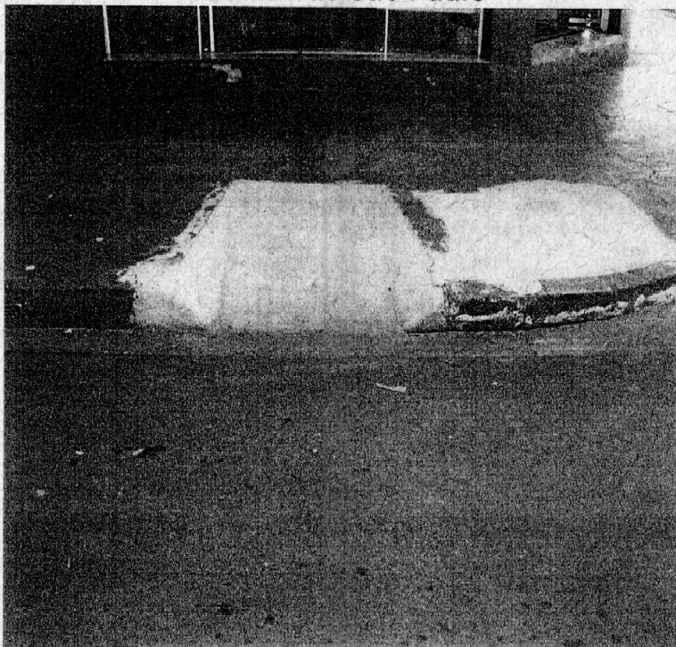
Figura 15 - Rampa de Acesso nas Calçadas do Setor Comercial da Avenida Siqueira Campos.
