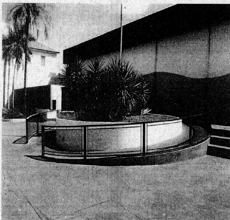
Figura 44 – 1º Rampa de acesso do Ginásio Silvio Magalhães Padilha.
