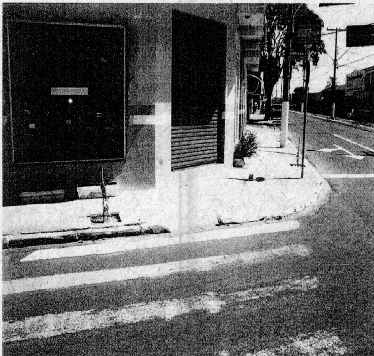
Figura 13 – Rampa de Acesso nas Calçadas do Setor Comercial da Avenida Siqueira Campos.
