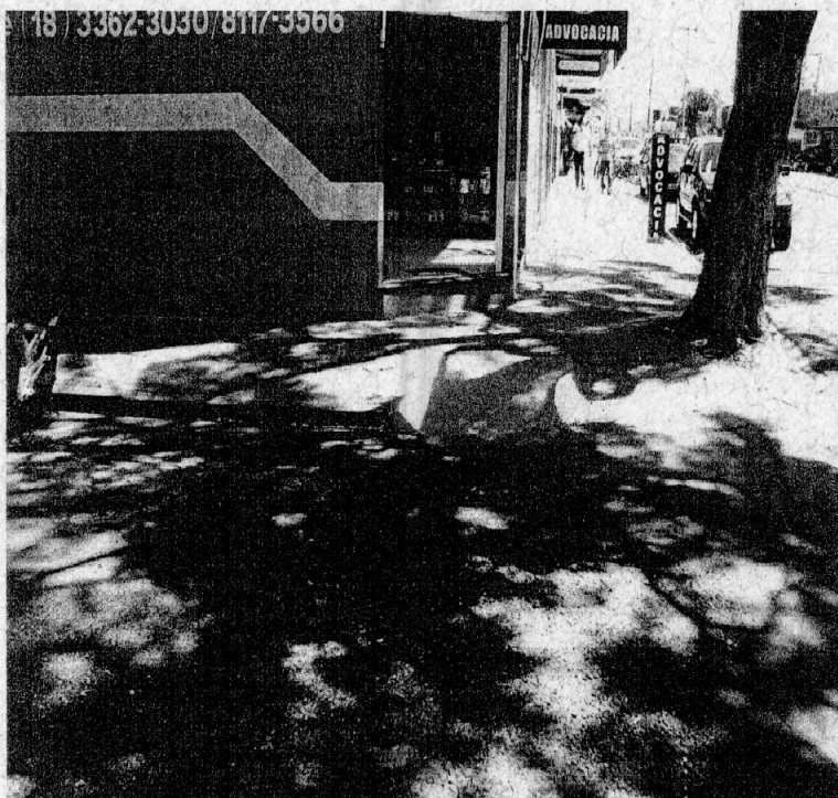
Figura 14 – Rampa de Acesso nas Calçadas do Setor Comercial da Avenida Siqueira Campos.
