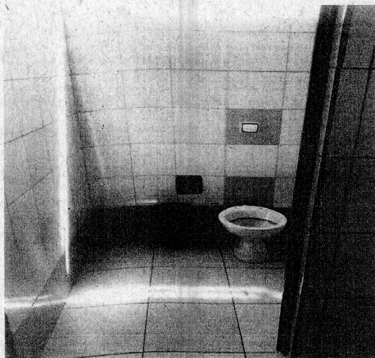
Figura 40 – Sanitário Acessível Escola Alexandrina Penna.
