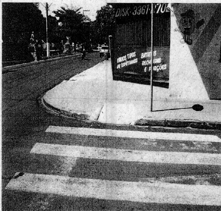
Figura 17 - Rampa de Acesso nas Calçadas do Setor Comercial da Avenida Siqueira Campos.
