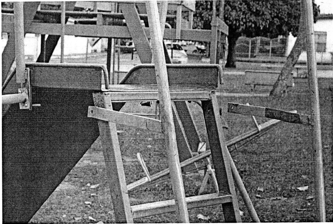
Escorregador em péssimo estado de conservação. Falta de parafusos nas barras de apoio para as mãos, bem como a grande presença de ferrugem no brinquedo.
