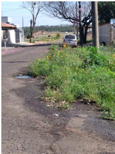
Tal medida se faz necessária, pois a via do trecho citado está sendo tomada pelos buracos e pela vegetação que invade o logradouro, o que a tornará intransitável se não for realizado tais reparos.
