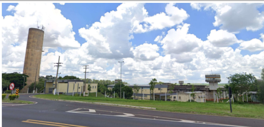
Imagem 1 – Fachada do imóvel
