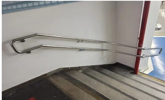
FIGURA 10 : CORRIMÃO DUPLO FIXADO NA ALVENARIA ( MODELO 3 )
