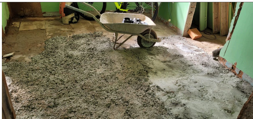
Imagem 04 – Concreto para nivelamento do piso
