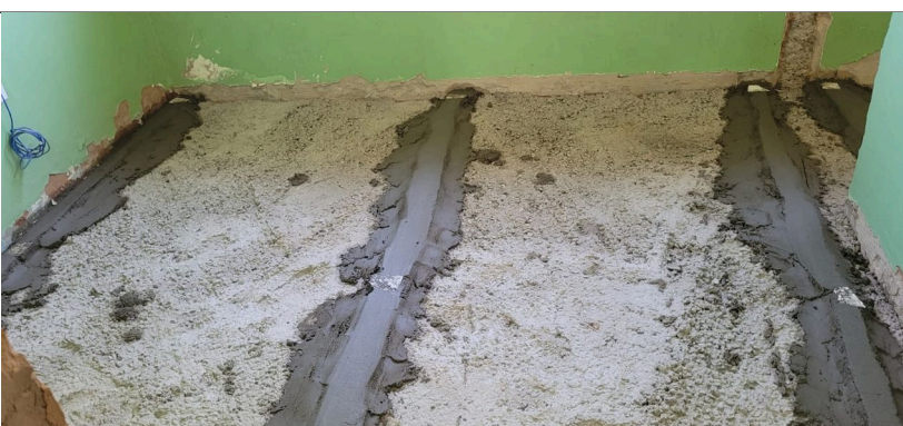
Imagem 10 – Concreto para nivelamento do piso
