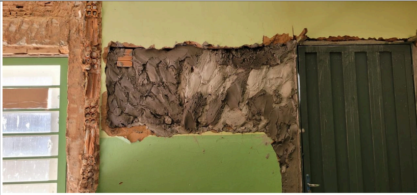
Imagem 11 – Retirada de esquadria metálica
