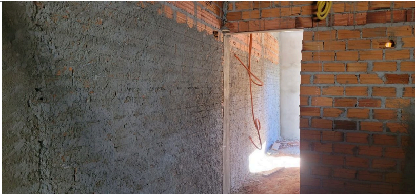
Imagem 04 – Chapisco e tubo PVC flexível
