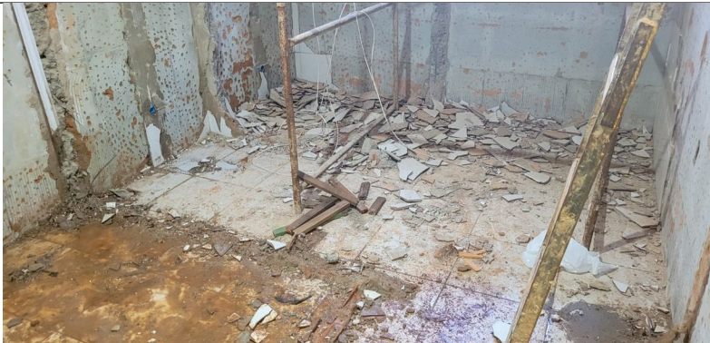
Imagem 09 – Demolição de revestimento cerâmico e alvenaria
