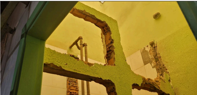
Imagem 10 – Demolição de alvenaria
