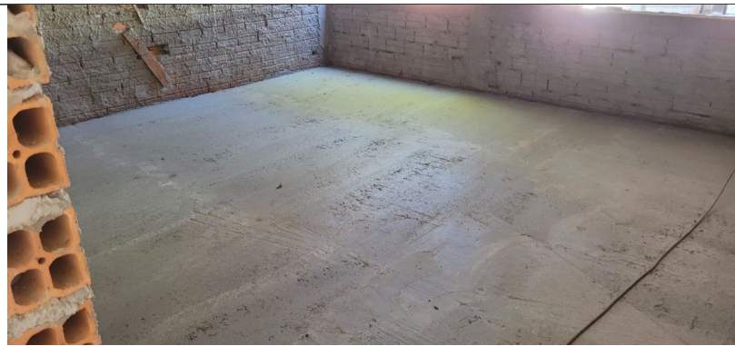
Imagem 07 – Contrapiso e chapisco
