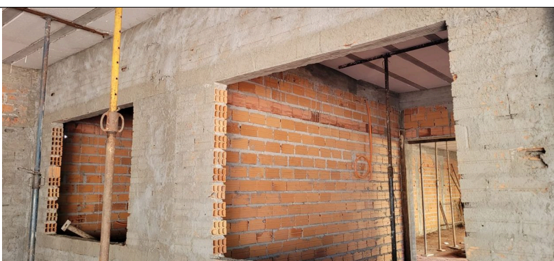
Imagem 06 – Alvenaria e chapisco
