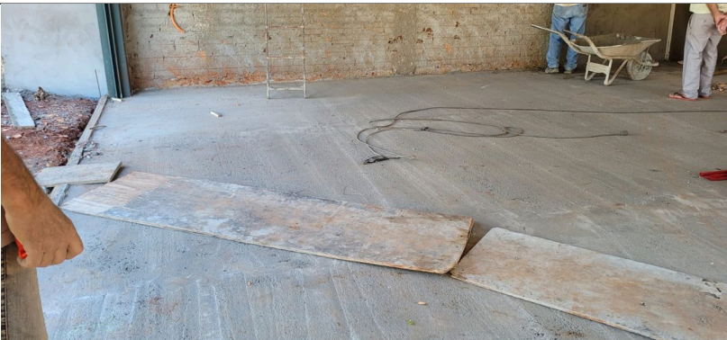
Imagem 10 – Contrapiso, chapisco e reboco
