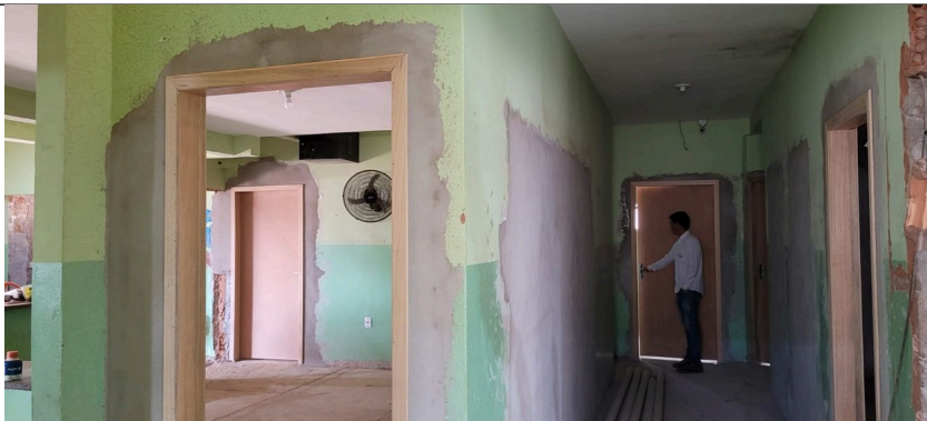
Imagem 06 – Reboco, batente e porta
