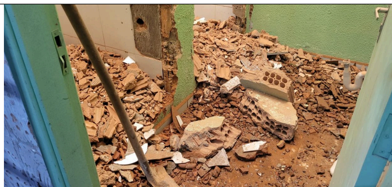
Imagem 06 – Demolição de alvenaria
