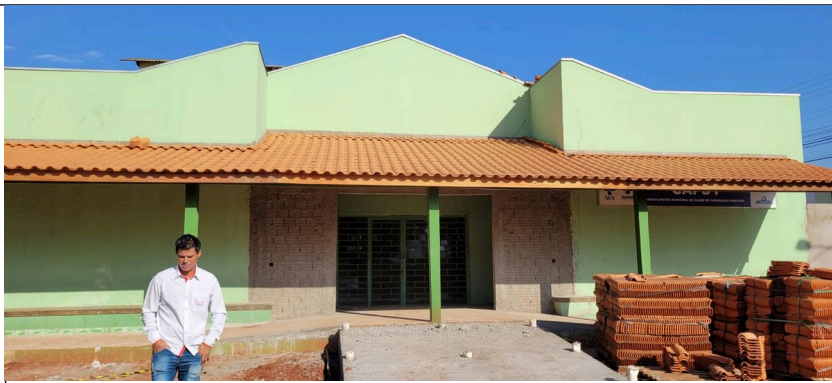
Imagem 10 – Telhado, ripa e testeira
