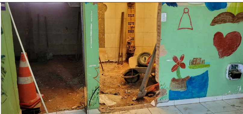
Imagem 07 – Demolição de alvenaria
