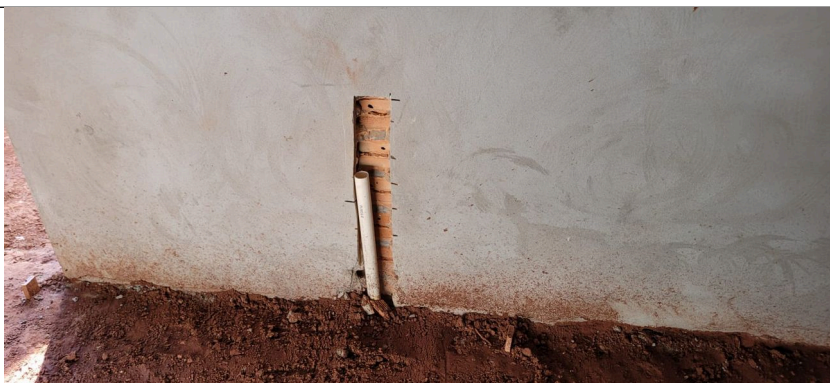
Imagem 04 – Tubo PVC para esgoto
