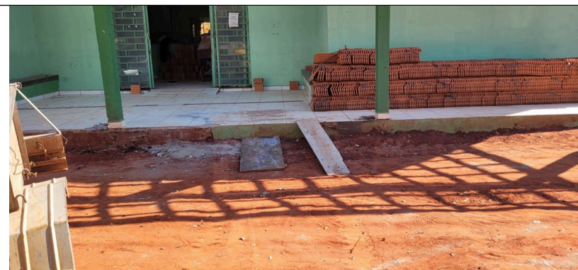
Imagem 02 – Compactação mecânica do solo
