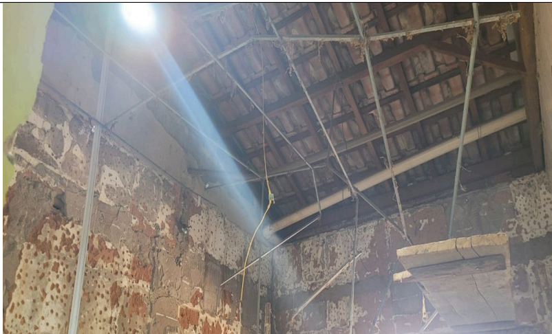
Imagem 12 – Retirada de forro
