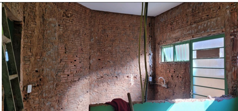
Imagem 08 – Demolição de revestimento cerâmico
