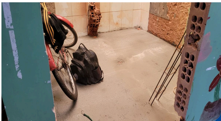
Imagem 03 – Contrapiso e nivelamento
