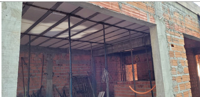
Imagem 03 – Instalação da laje
