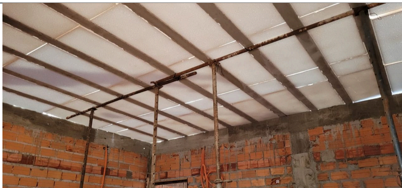
Imagem 02 – Instalação da laje
