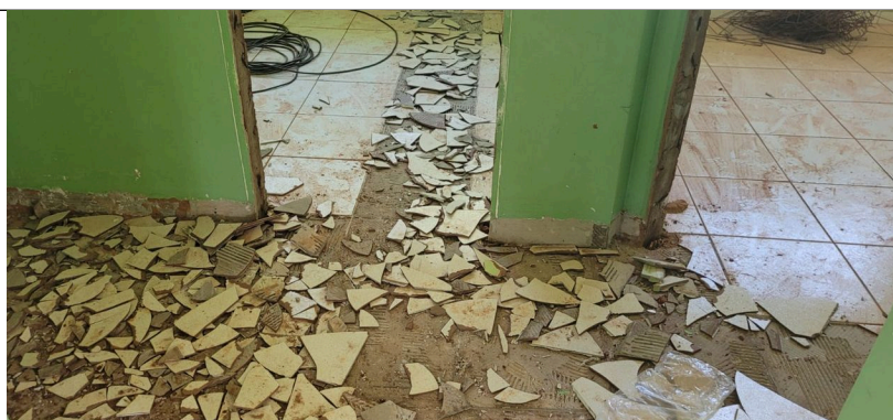
Imagem 05 – Demolição de revestimento cerâmico
