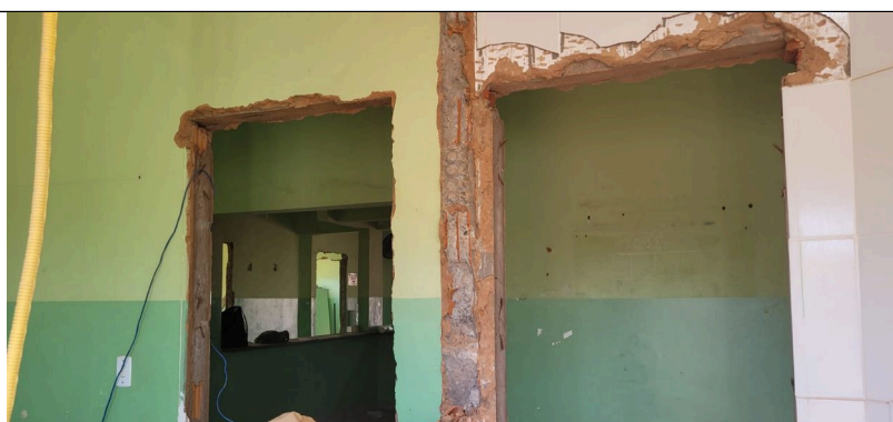
Imagem 03 – Retirada de portas e batentes
