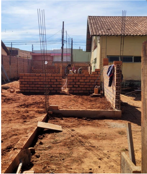
Imagem 03 – Baldrame, ferragem dos pilares e alvenaria
