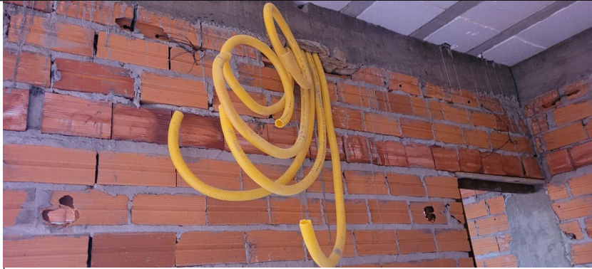
Imagem 07 – Alvenaria e tubo flexível
