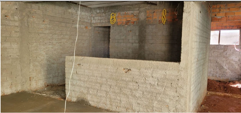
Imagem 06 – Tubo PVC flexível e chapisco
