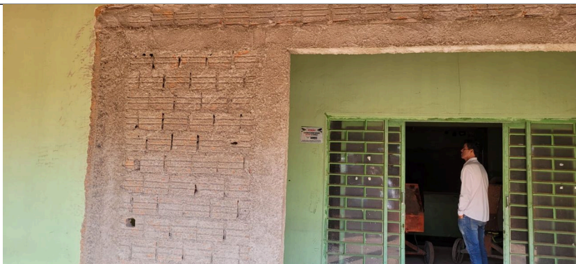
Imagem 9 – Alvenaria, Chapisco e Emboço
