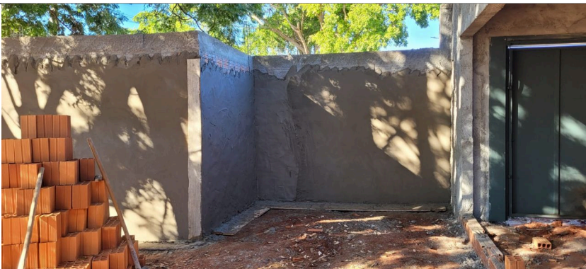
Imagem 9 – Chapisco e Emboço
