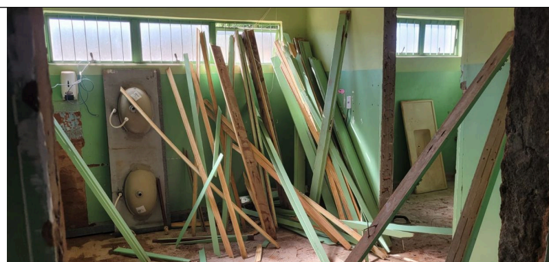
Imagem 07 – Batentes retirados
