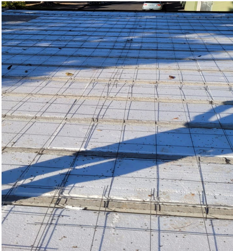
Imagem 01 – Malha para laje
