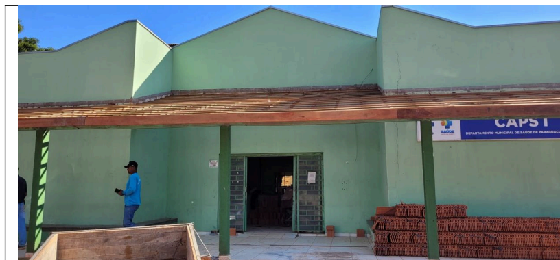
Imagem 01 – Retirada das telhas de barro
