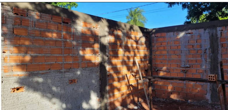
Imagem 02 – Construção do muro
