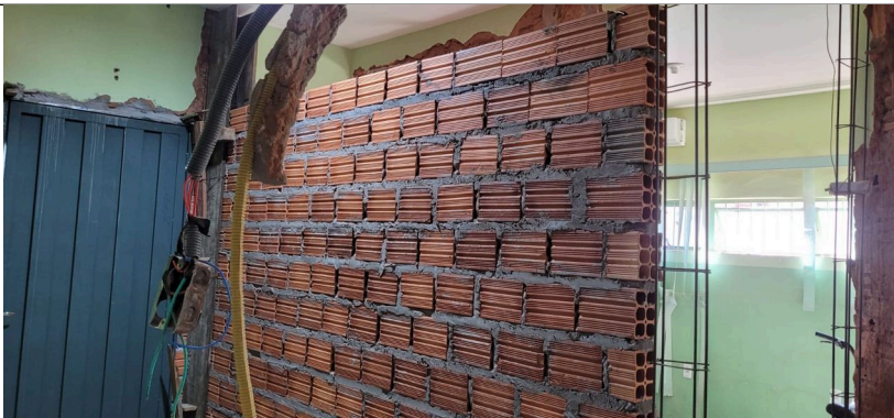
Imagem 05 – Construção de alvenaria
