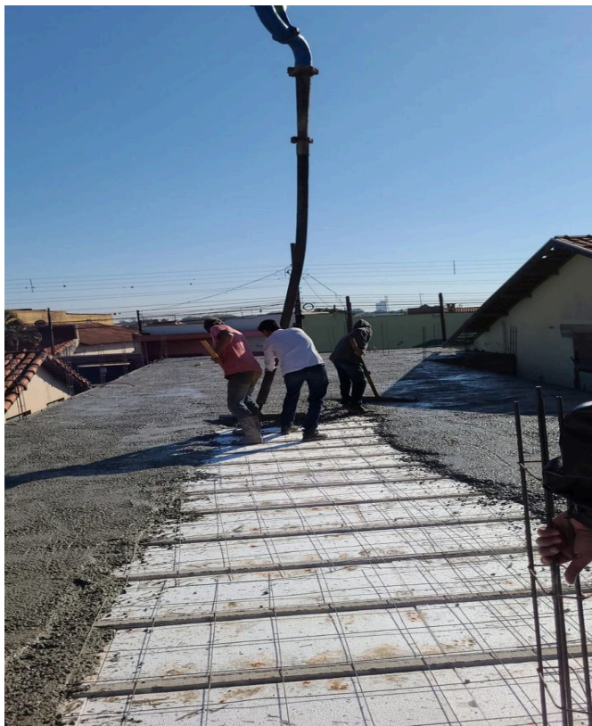
Imagem 01 – Concretagem da laje
