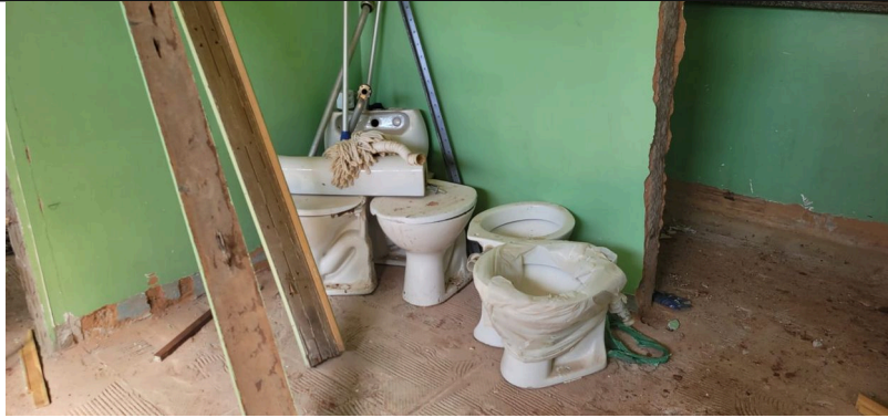
Imagem 08 – Retirada de aparelho sanitário
