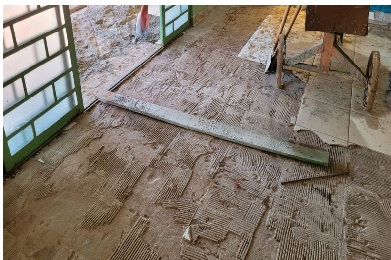
Imagem 02 – Retirada de pisos
