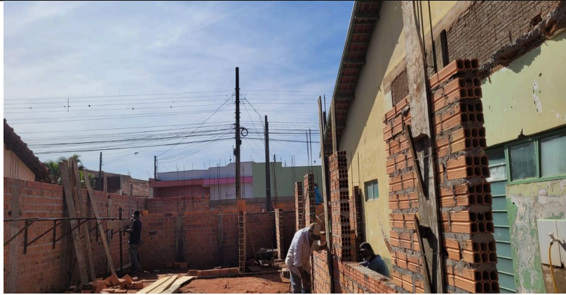
Imagem 06 – Concretagem dos pilares
