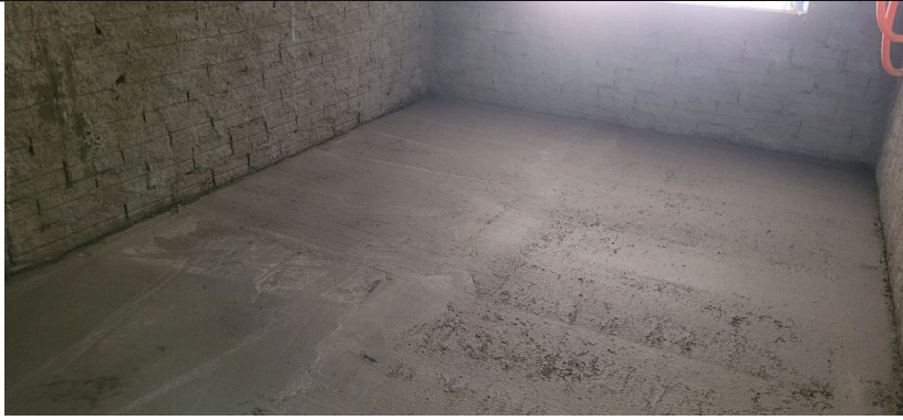
Imagem 08 – Contrapiso e chapisco
