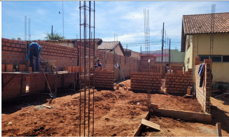
Imagem 04 – Baldrame, ferragem dos pilares e alvenaria
