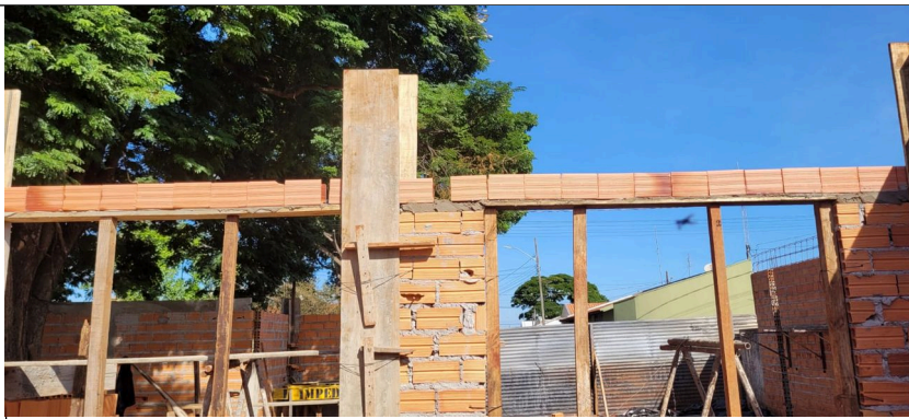
Imagem 03 – Verga e contraverga em cerâmica
