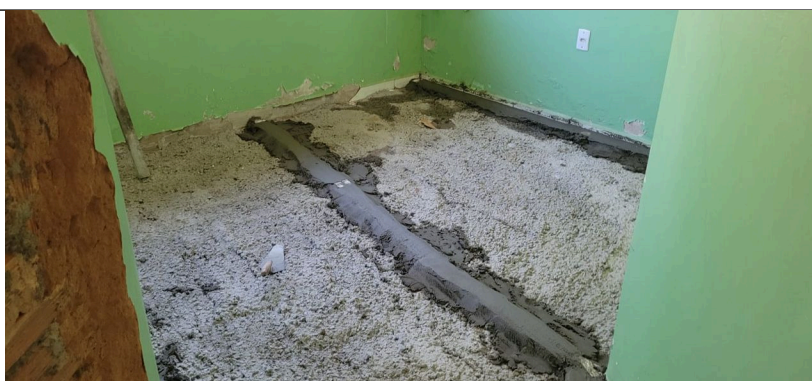
Imagem 09 – Concreto para nivelamento do piso
