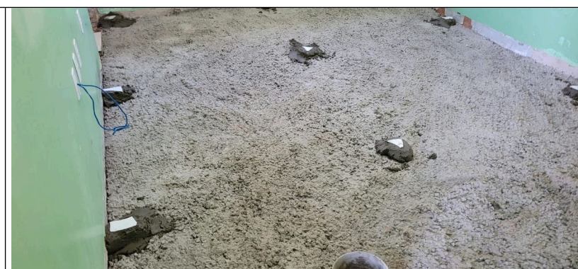
Imagem 03 – Concreto para nivelamento do piso
