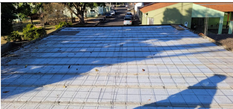
Imagem 05 – Instalação da laje
