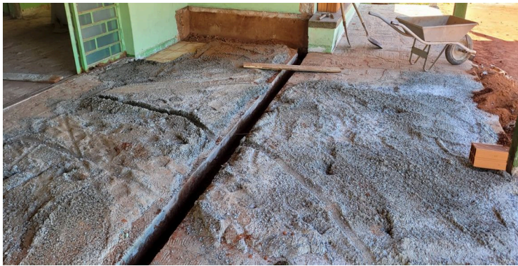
Imagem 06 – Concreto para nivelamento de piso
