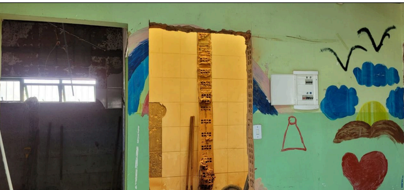
Imagem 06 – Demolição de alvenaria
