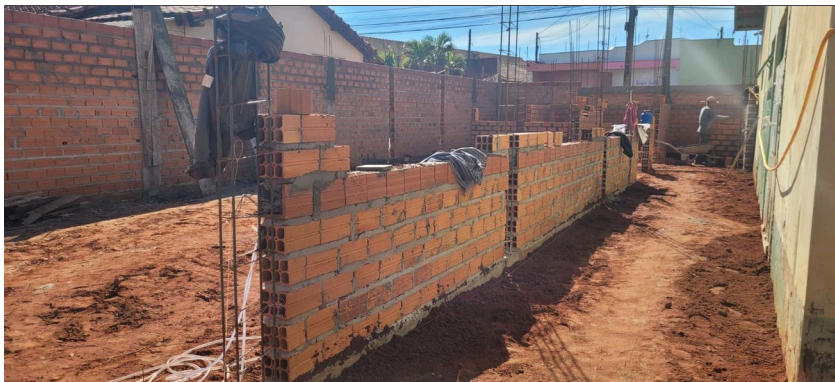
Imagem 02 – Verga e contraverga em cerâmica
