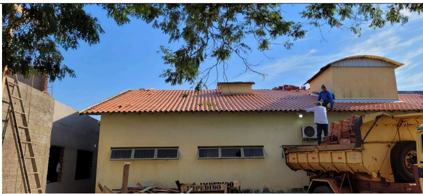
Imagem 05 – Telhado e ripa
