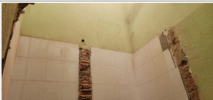
Imagem 01 – Demolição de parede
