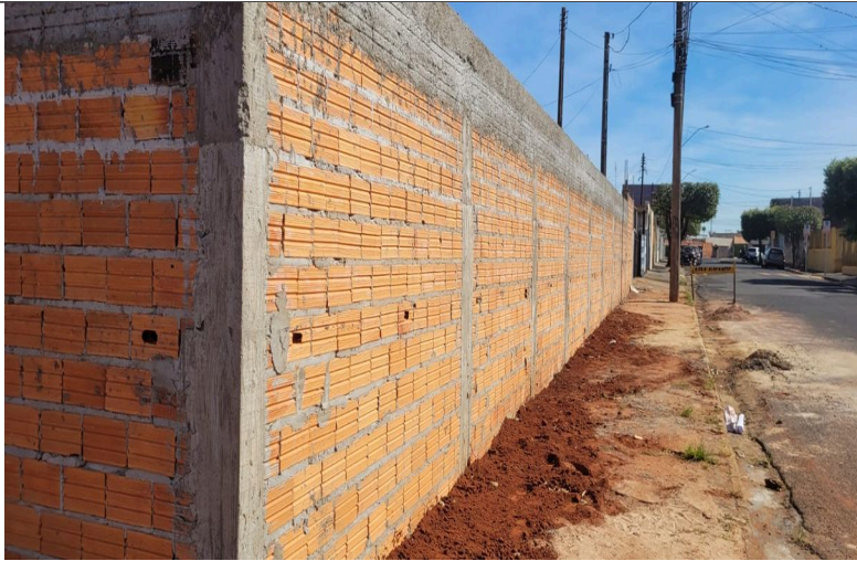
Imagem 11 – Construção do muro
