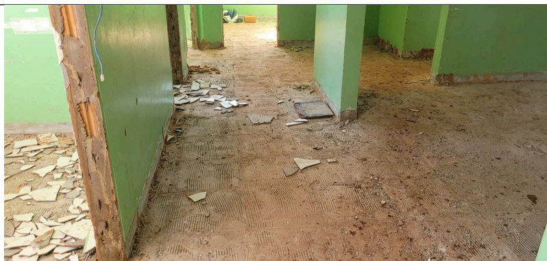
Imagem 04 – Demolição de revestimento cerâmico
