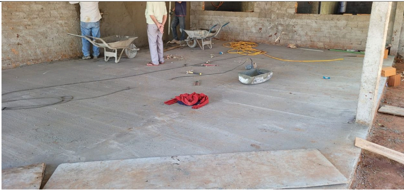
Imagem 09 – Contrapiso, chapisco e reboco
