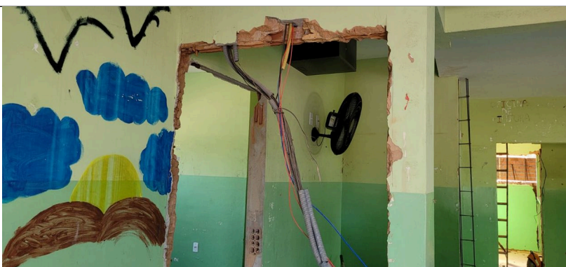
Imagem 05 – Demolição de alvenaria
