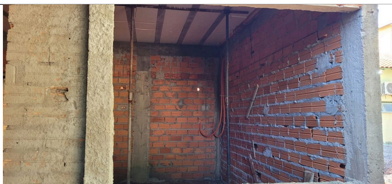
Imagem 04 – Alvenaria, laje e tubo flexível
