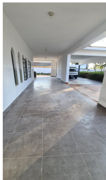
Revestimento do piso do corredor
