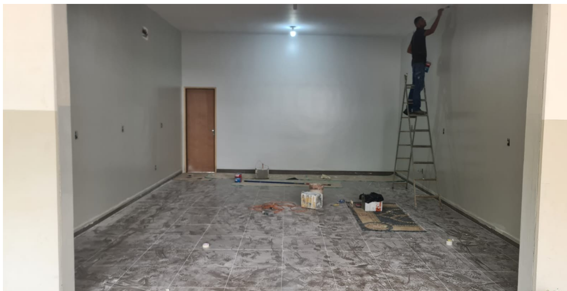
PAREDE PINTADA E REVESTIMENTO DO PISO COLOCADO
