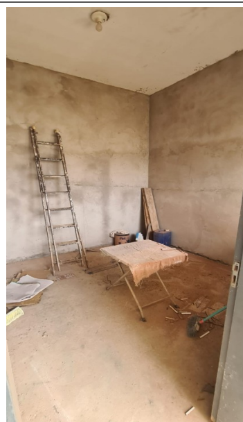
PAREDE REBOCADA DA COZINHA
