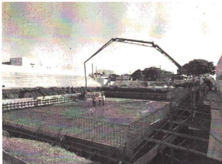
Ilustração 028 - Obras da Piscina Municipal
