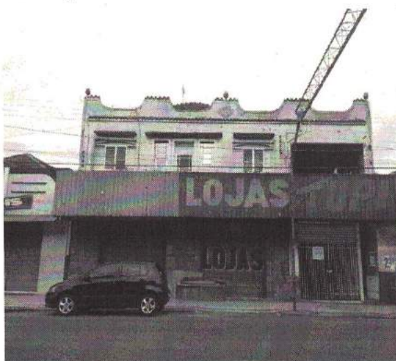
Ilustração 069 - Prédio Avenida Brasil
